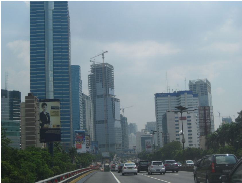
Jakarta中心部の高速道路から見える 高層ビル群、建築中の高層ビルが多い のに驚く
